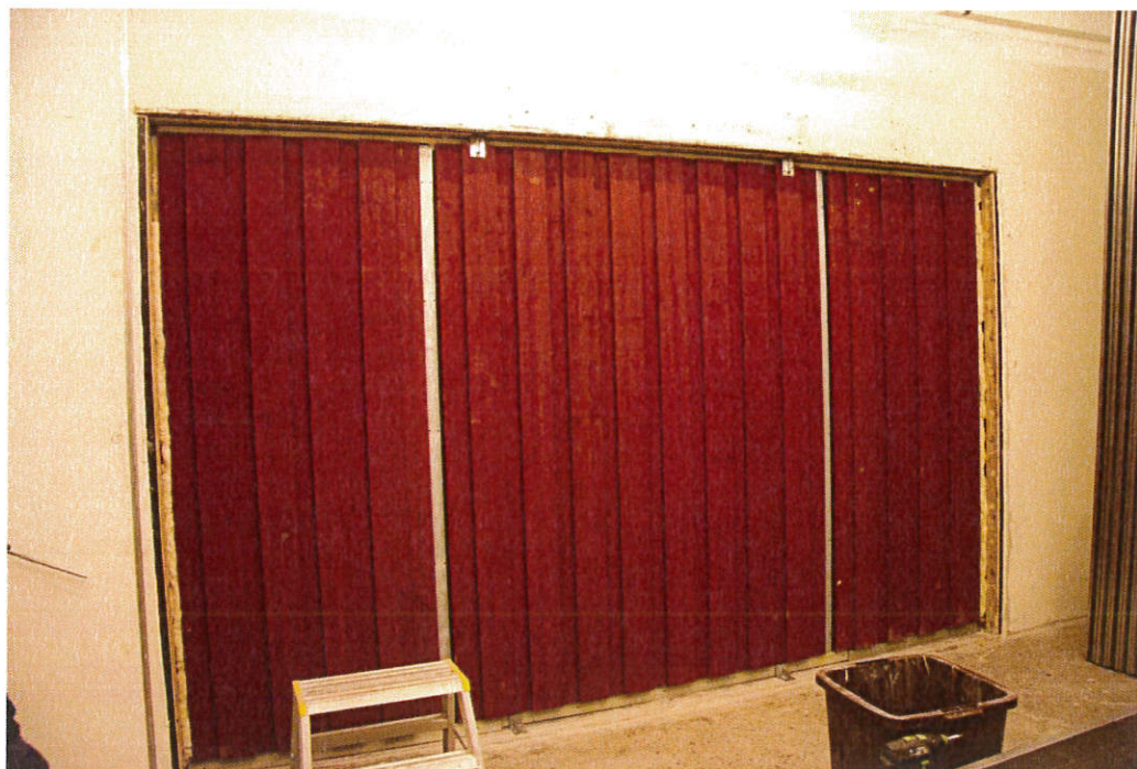
Bild 3 – De två stolparna synliga.
